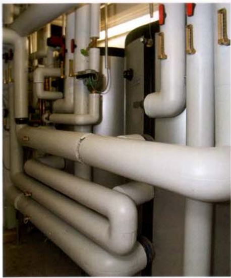
Hinter den isolierten Rohren befinden sich die Wassertanks, in denen Schollin das heiße Wasser zwischenspeichert, das zum Beispiel für den Betrieb der Korbwaschanlage oder für die Heizung benötigt wird.
