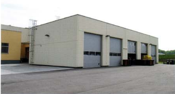
Baulich getrennt ist die Halle für die Entsorgung von Retouren. Es besteht keine direkt Verbindung zur Produktion.
