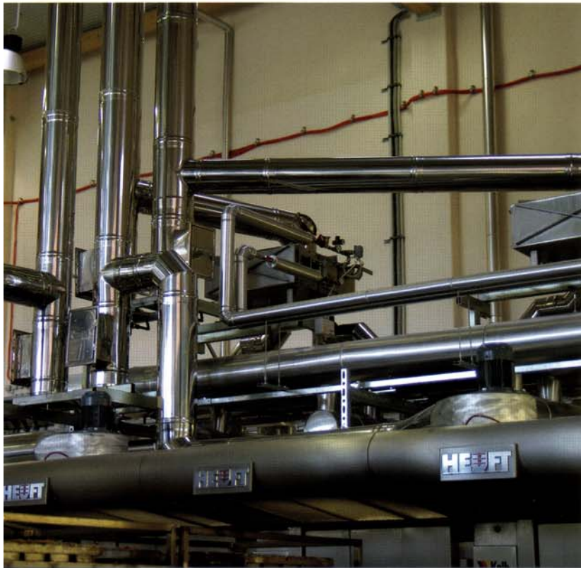
Der Focus lag bei der Energierückgewinnung auf den zwei wichtigsten Bereichen, die überschüssige Energie liefern: Öfen (Wärmetauscher in Abzug) und Kälte (Plattenwärmetauscher). Allein diese beiden Bereiche liefern mehr Energie aus Abwärme, als die Produktion eigentlich braucht.
