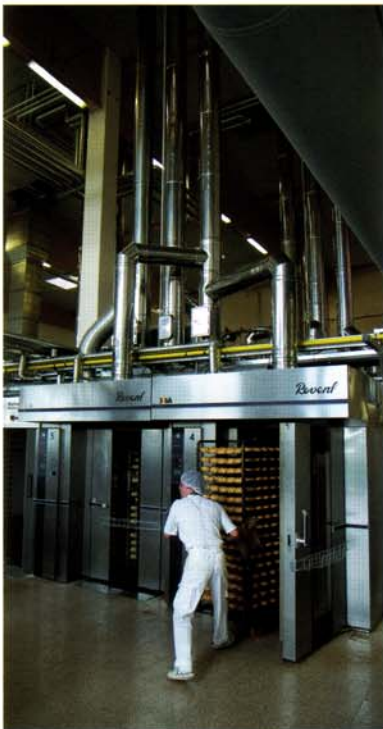
Eine hohe Deckenhöhe hat im Ofenbereich den Vorteil, dass die warme Luft ungehindert nach oben aufsteigen kann und nicht die Temperatur im Arbeitsbereich erhöht.
